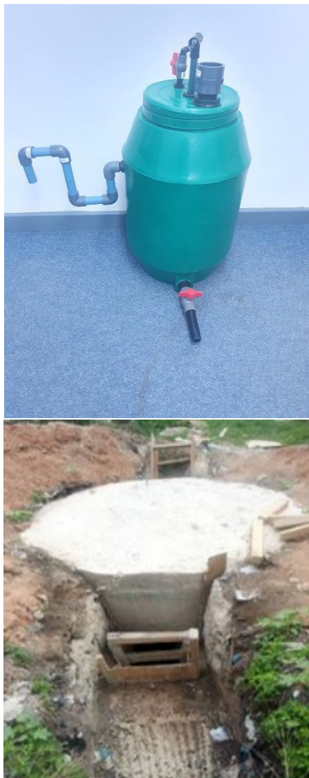
Слика 1. Изработка на дигестор за биогас (извор University of Cape Coast - проект DIVAGRI)
