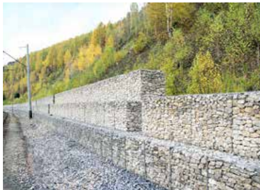
Слика 29. Габиони – димензии и структура од габион
